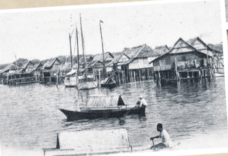
PULAU BRANI: Penduduk mendirikan rumah di atas tiang dekat dengan laut agar mudah ke perahu masing-masing.
